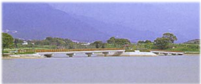
写真は粕屋町ホームページより
