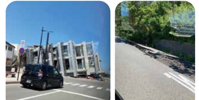
倒壊したビルや陥没した道路が手つかずの状態でした
